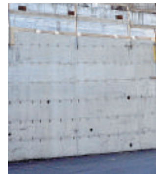
Un muro in cemento armato
